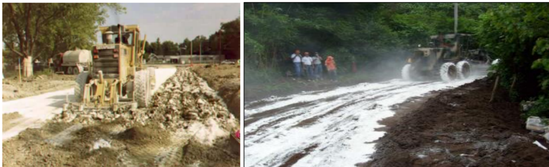
Figura 8 Estabilización con cal
