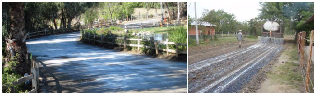
Figura 9 Estabilización con polímeros
