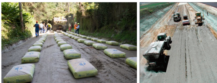
Figura 7 Estabilización con cemento
