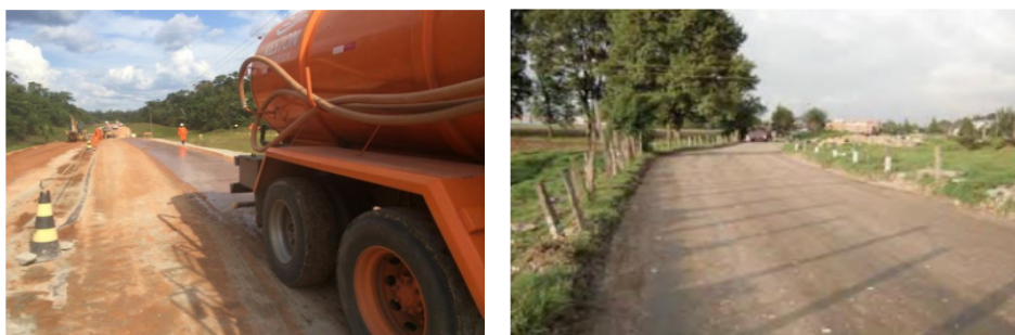
Figura 10 Estabilización con nanopartículas
